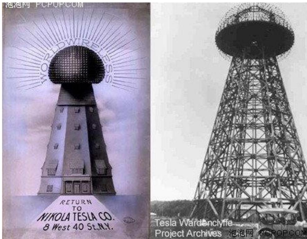
Wardenclyffe Tower（瓦登克里夫塔）—1904年建于纽约长岛，占地200英亩，高154英尺，顶部为直径100英尺的巨大铜线圈。由于资金问题终止，1917年被毁掉。
