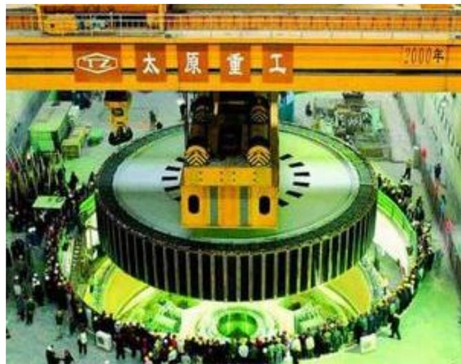
三峡工程首台机组——2号机转子吊装到位。其最大直径18.4米，高3.4米，重1694.5吨，单机容量70万千瓦。已于2003年7月投产发电。
